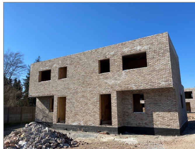
Foto 11: evolutie bouwwerken - achterzijde gebouw
