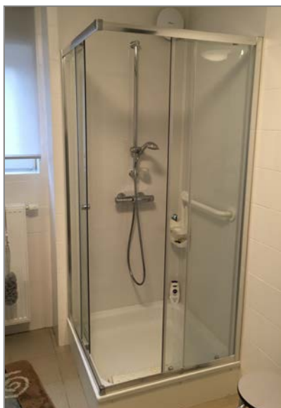
Foto 5: na de renovatie bad vervangen door douche
