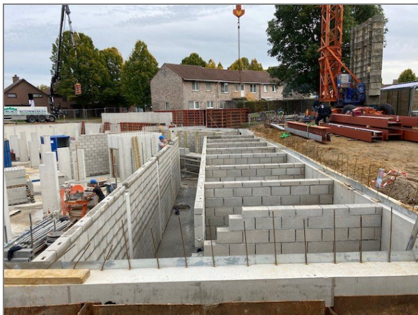
Foto 9: parkeergarage en bergingen
