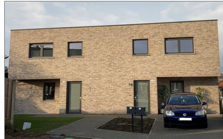
Foto 3: aanzicht langs de straat
