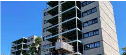
Genk - Driehoeven - Azalealaan 2 en 4 - deelrenovatie
